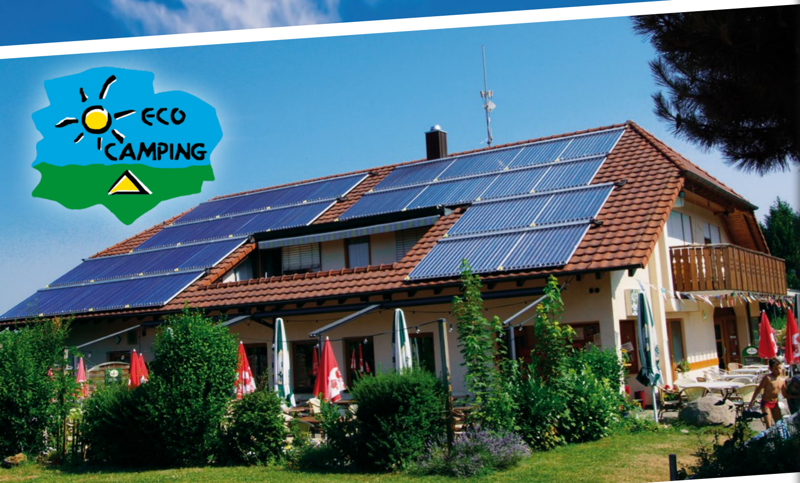
Warmwasser mit Solarenergie
